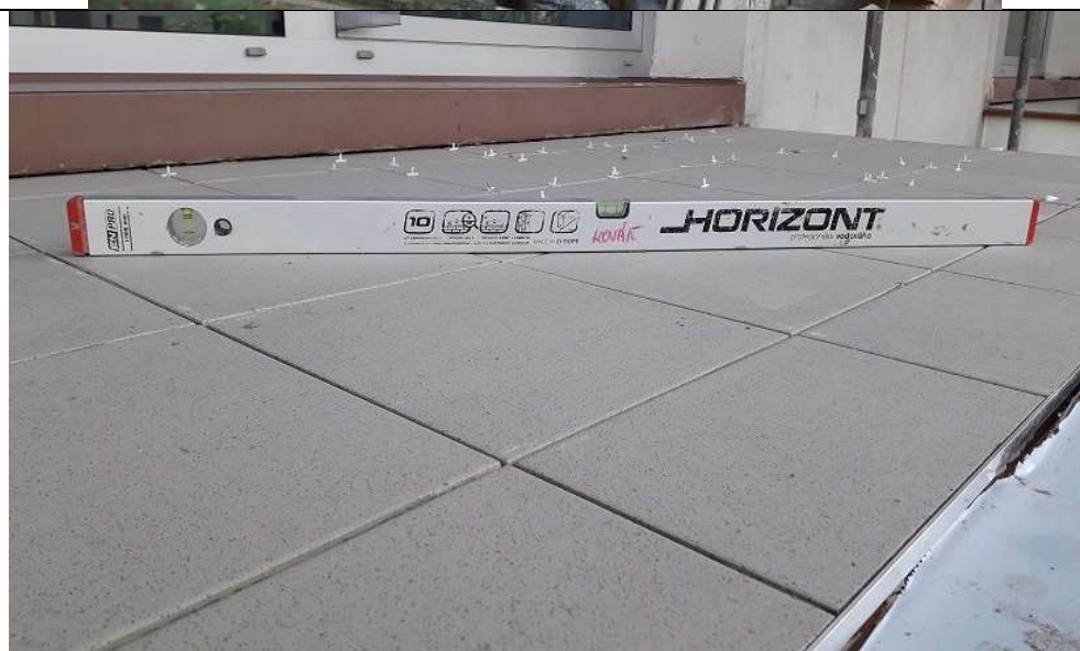
Pokládka dlažby – kontrola rovinatosti (sekce H1)
