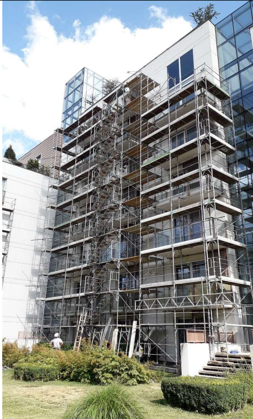
Montáž lešení (sekce J1)
